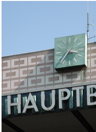
Braunschweig, Hauptbahnhof Detail Foto: Ulrich Knufinke, 2012
