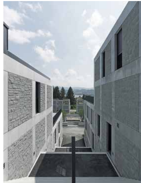
Giessen-Areal in Meilen, Zürichsee
